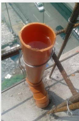
3. Air Con Drain Line
